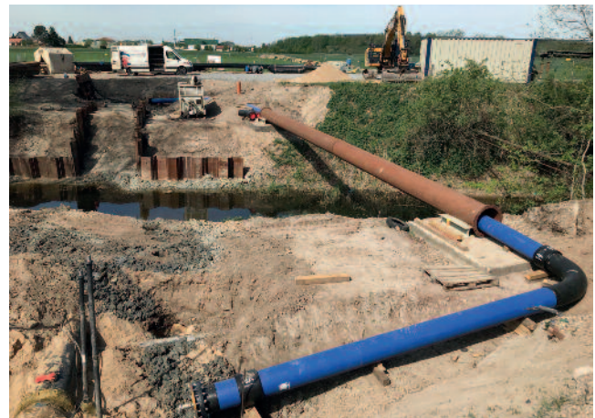
Die Dükerbaustelle am Floßgraben.
