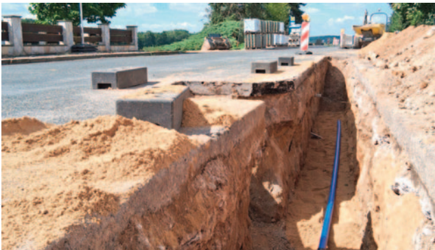
In der Dorfstraße werden neue Trinkwasserleitungen verlegt.
