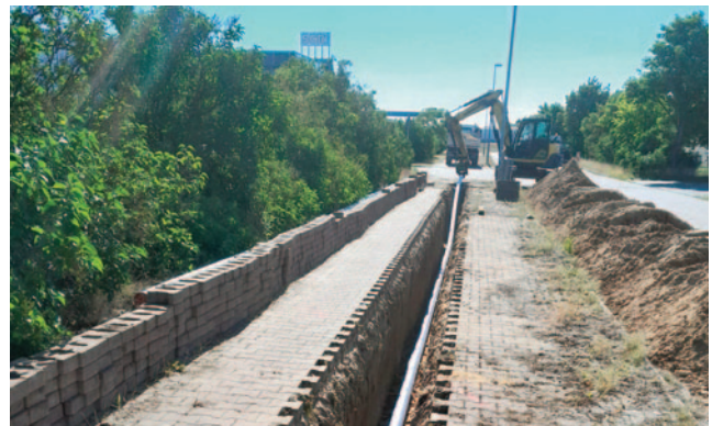
Die neue Trinkwasserleitung in der Industriestraße D dient der stabileren Versorgung der beiden Industriegebiete.
