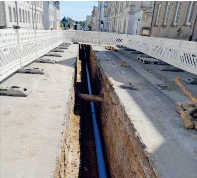
Neuerlegung der Rohrleitungen auf der Lange Straße.
