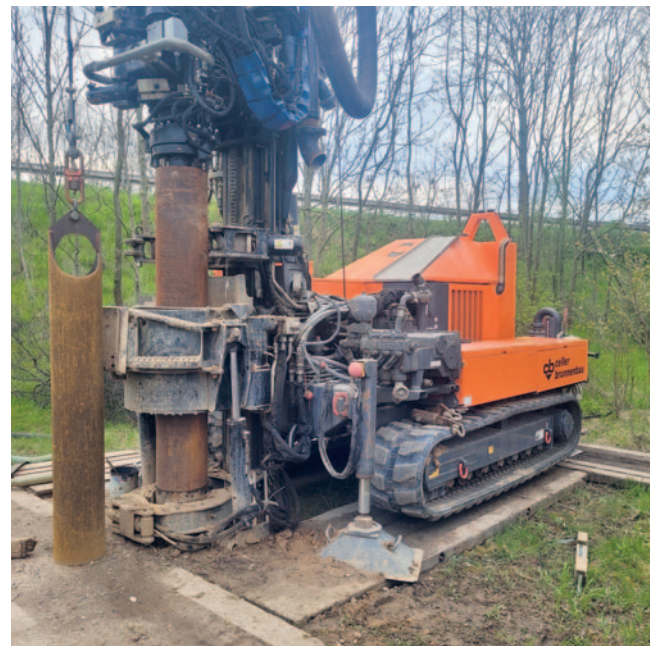
Mit diesem Bohrggerät wurde eine neue Anodenanlage installiert.
